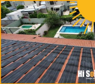
CLIMATIZACIÓN SOLAR DE PISCINA TEJAS 2. CÓRDOBA
