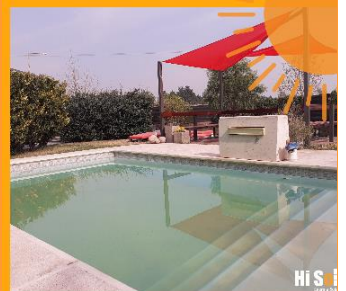
CLIMATIZACIÓN SOLAR DE PISCINA LA MORADA. CÓRDOBA
