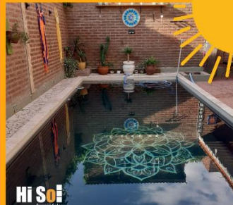
CLIMATIZACIÓN SOLAR DE PISCINA URCA. CÓRDOBA
