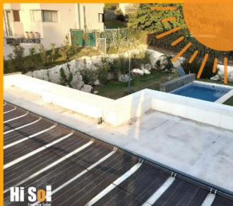
CLIMATIZACIÓN SOLAR DE PISCINA LA CALERA. CÓRDOBA
