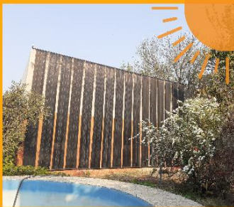
CLIMATIZACIÓN SOLAR DE PISCINA ALTO ALBERDI. CÓRDOBA
