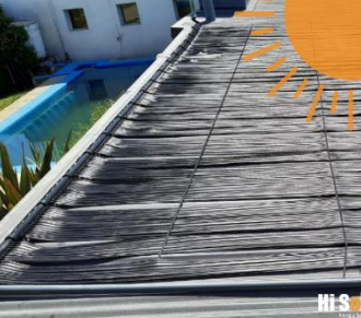
CLIMATIZACIÓN SOLAR DE PISCINA ALTA GRACIA. CÓRDOBA
