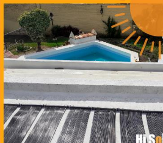
CLIMATIZACIÓN SOLAR DE PISCINA URCA. CÓRDOBA
