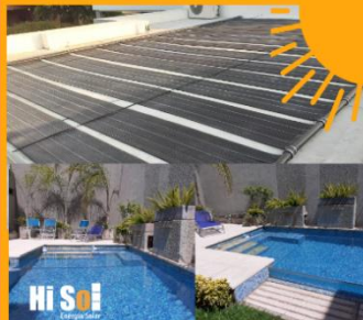
CLIMATIZACIÓN SOLAR DE PISCINA CÓRDOBA CAPITAL
