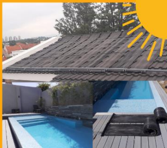
CLIMATIZACIÓN SOLAR DE PISCINA URCA. CÓRDOBA
