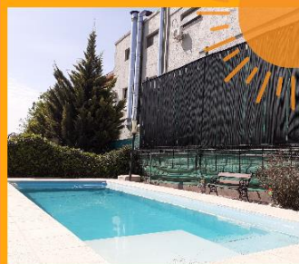
CLIMATIZACIÓN SOLAR DE PISCINAS VALLE ESCONDIDO. CÓRDOBA
