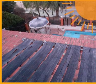
CLIMATIZACIÓN SOLAR DE PISCINAS AGUA DE ORO. CÓRDOBA
