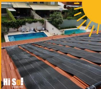
CLIMATIZACIÓN SOLAR DE PISCINA TEJAS 2. CÓRDOBA
