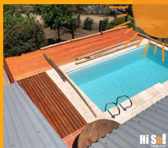
CLIMATIZACIÓN SOLAR DE PISCINA EL MANZANO. CÓRDOBA
