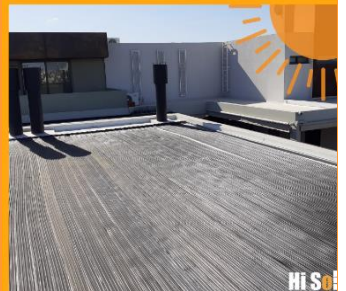
CLIMATIZACIÓN SOLAR DE PISCINA 7 SOLES. CÓRDOBA
