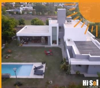
CLIMATIZACIÓN SOLAR DE PISCINA LA CALERA. CÓRDOBA
