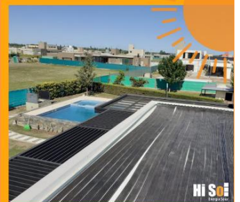
CLIMATIZACIÓN SOLAR DE PISCINA 7 SOLES. CÓRDOBA
